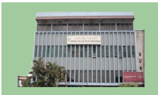
Rajah 1. Bangunan guru yang dibina pada 1963
